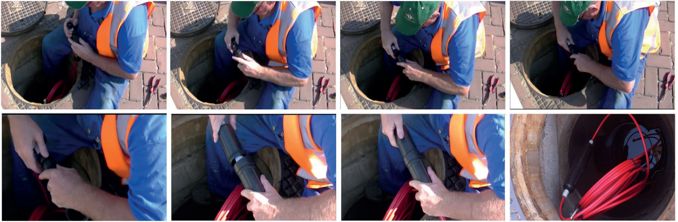
Figuur 3: De innovatieve koppeling om glasvezelkabels onderling te verbinden in de rioolpraktijk
